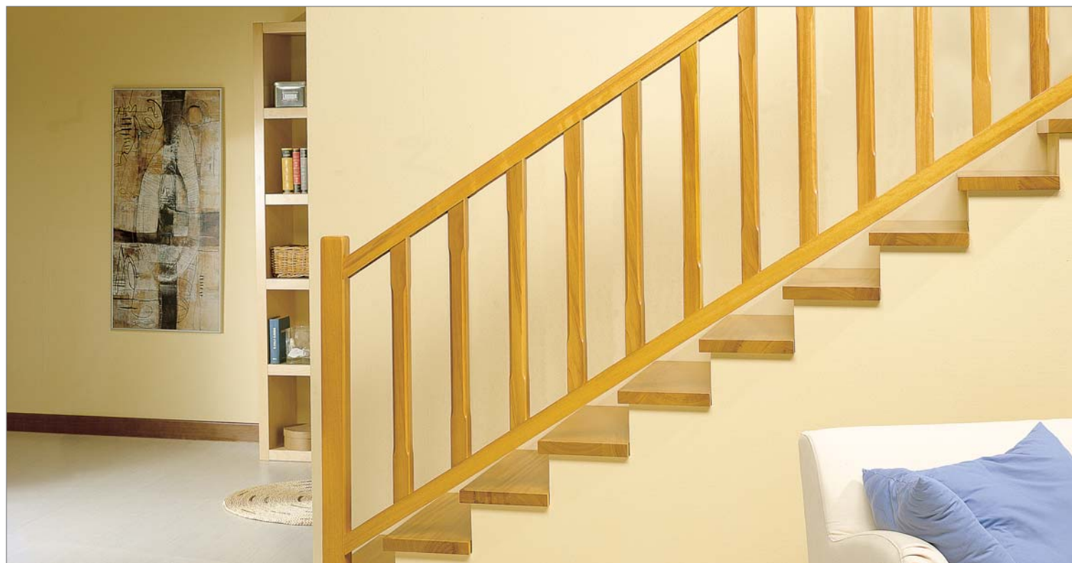
Ringhiera realizzata in Iroko M. 610.
